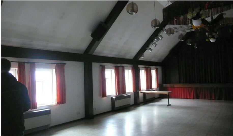
Bild 6 - Klimatruhe/Heizkörper mit Außenluftzumischung
